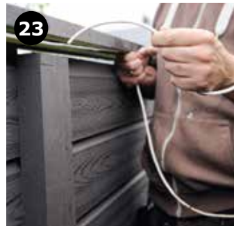
23 Tilslutning af selve ledningen til LED skjules ved at føre den ned igennem den sidste stolpe, og nederst på stolpen bore hul, så ledningen kan komme ud og tilsluttes strøm. Endnu et godt fif er, løbende at tjekke LED-ledningerne for at kontrollere, at der er lys i.
