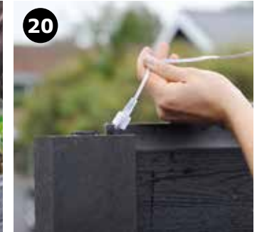
20 Kirkedal LED lys, har fordelen at kunne "gemme" synlige ledninger i stolperne. Hvis der ikke ønskes LED lys ned ad stolpen føres ledningen inde i topprofilen over stolperne, dette giver et mere eksklusivt look.
