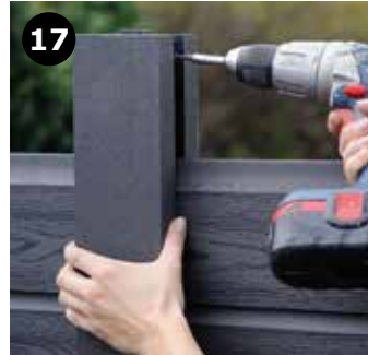
17 K11 Topklods skrues fast igennem stolpen med Kirkedal skruer.
