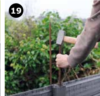
19 Hvis dit hegn sættes op i særligt udsatte områder, kan du med fordel sætte tentorstål ned igennem stolperne og fylde tørbeton i midten af stolperne. Dette foreskrives også ved hegn der er højere end 1,7 mtr.
