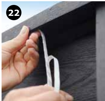
22 LED ledningen klistres på indvendig topprofil. For yderligere fastgørelse, brug evt. montage lim.
